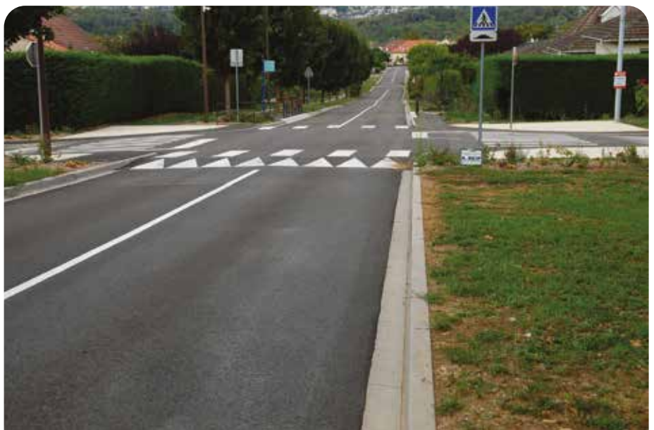
RD 115b, entrée du village côté Frolois
