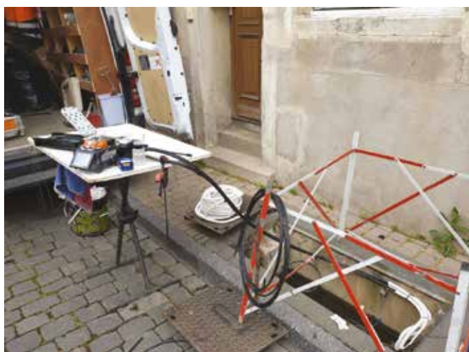
Une entreprise sous traitante passe la fibre dans les chambres de tirages
