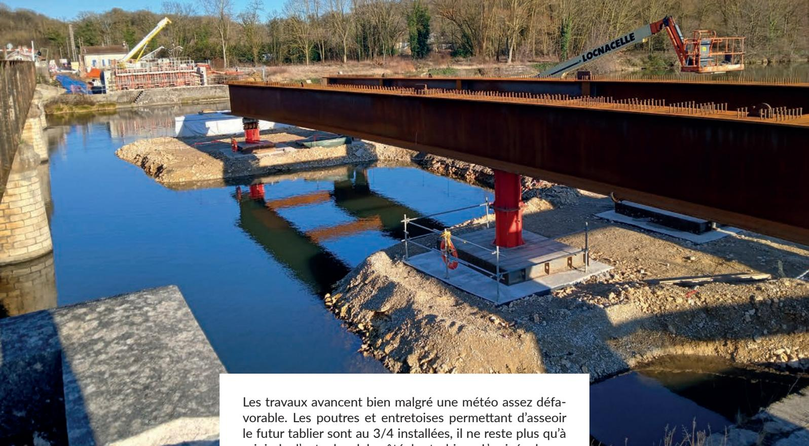
Les travaux avancent bien malgré une météo assez défavorable. Les poutres et entretoises permettant d'asseoir le futur tablier sont au 3/4 installées, il ne reste plus qu'à rejoindre l'autre bord du côté des turbines. L'arrivée de ces poutres sur le chantier et leur installation est assez spectaculaire, et certains d'entre-vous ont même réalisé de jolis petits films vidéo. Les entreprises affirment être dans le timing prévu. D'autres nouvelles au prochain numéro.
